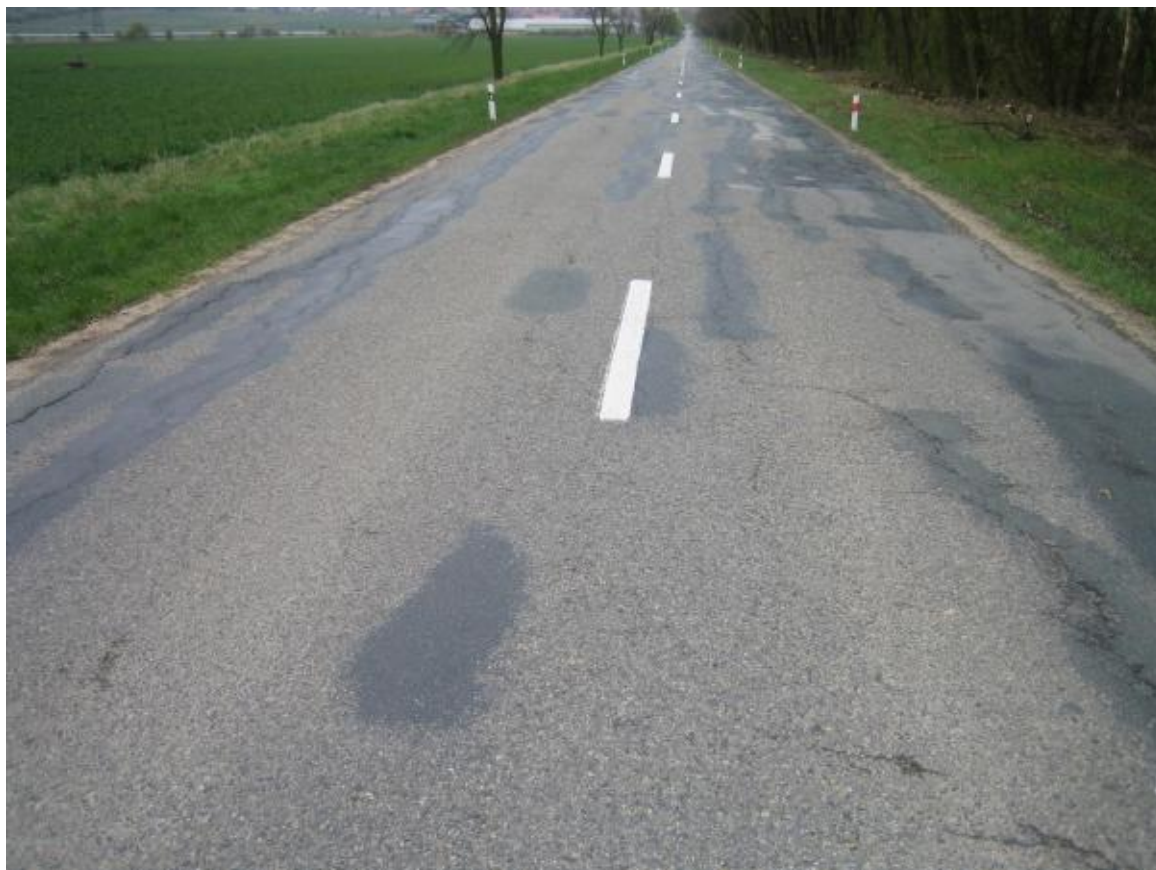
F26, km 16,310+ Podélné rozvětvené trhliny, síťové trhliny, nátěrové vysprávkky, plošné deformace podél okrajů vozovky
