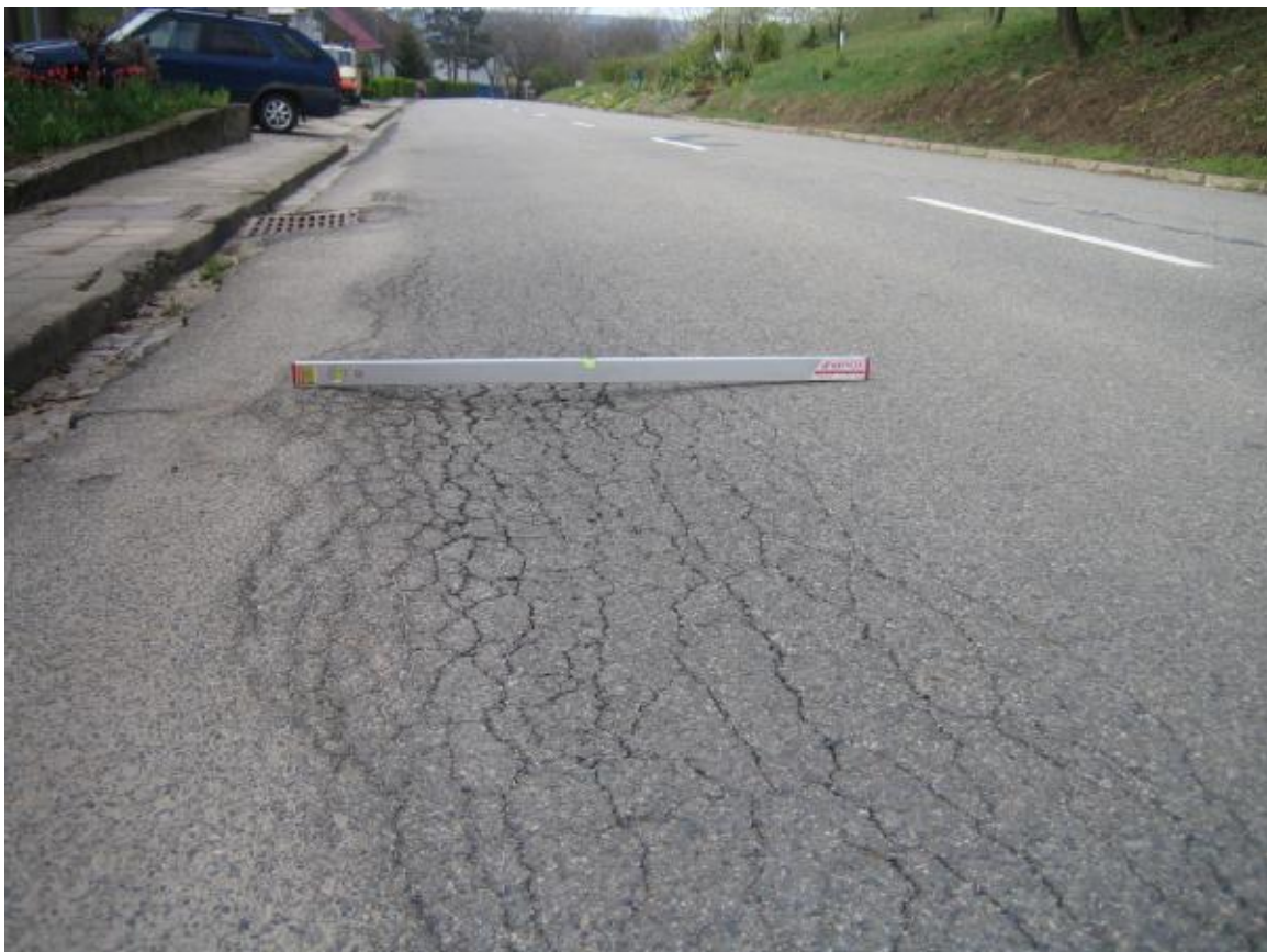
F40, km 18,450+ Sítové trhliny, plošné deformace poblíž kanalizační vpustě
