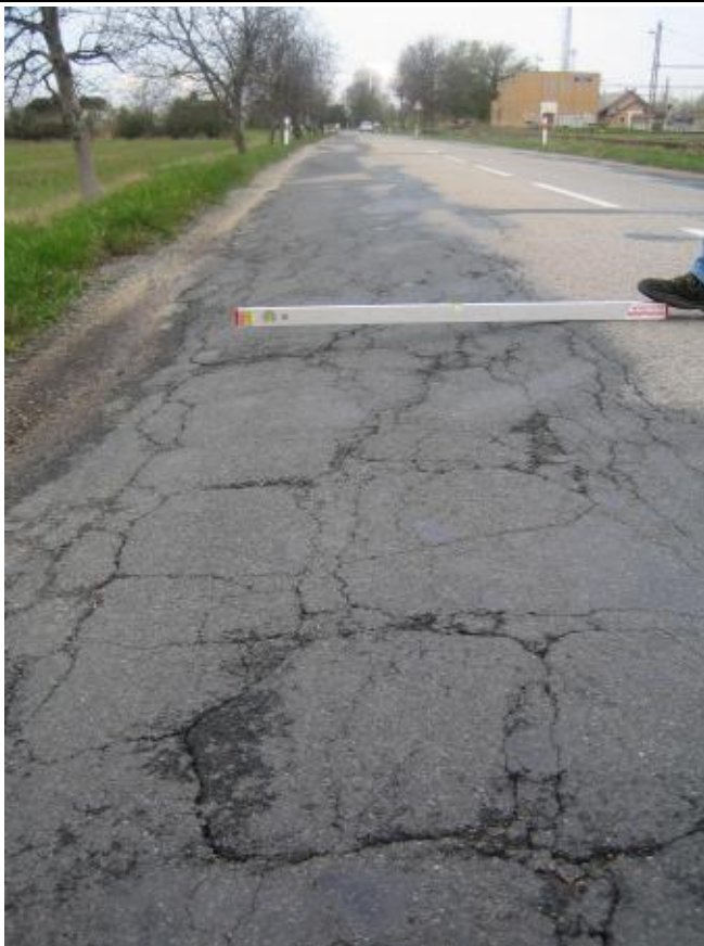
F18, km 15,750+ Síťové trhliny, nátěrové vysprávkky, plošné deformace
